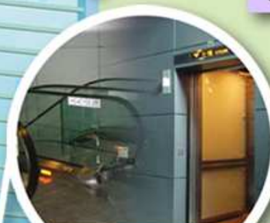
升降機及自動梯裝置 Lift & escalator installation
