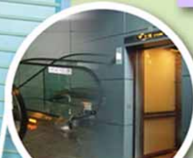
升降機及自動梯裝置 Lift & escalator installation
