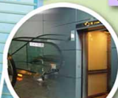
升降機及自動梯裝置 Lift & escalator installation
