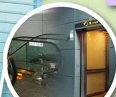
升降機及自動梯裝置 Lift & escalator installation
