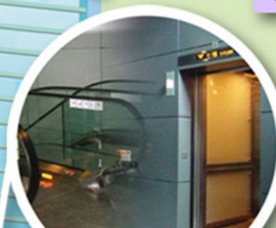
升降機及自動梯裝置 Lift & escalator installation
