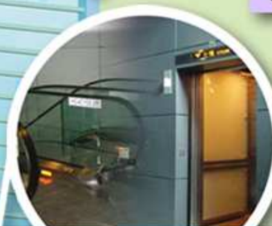
升降機及自動梯裝置 Lift & escalator installation
