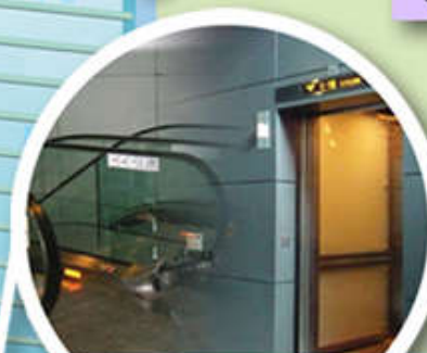
升降機及自動梯裝置 Lift & escalator installation
