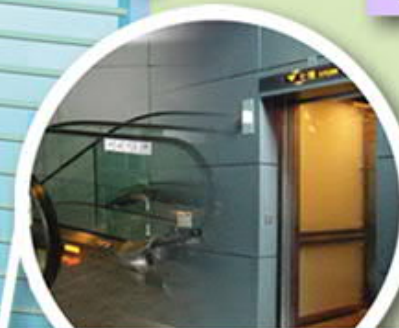
升降機及自動梯裝置 Lift & escalator installation
