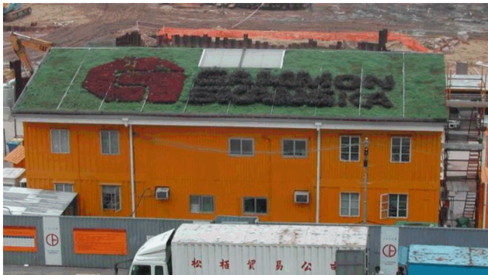
組圖四： 綠色建造工地辦公室現貌
