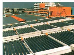
深圳太阳能空调热水系统 (14kW 供冷), 1987 年
